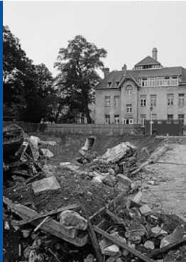
Abriß der Häuser 23/24 für den Neubau
